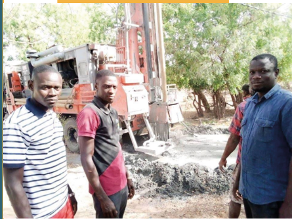
Les jeunes maraîchers bénéficiaires des forages équipés et le coordinateur terrain suivant les travaux
